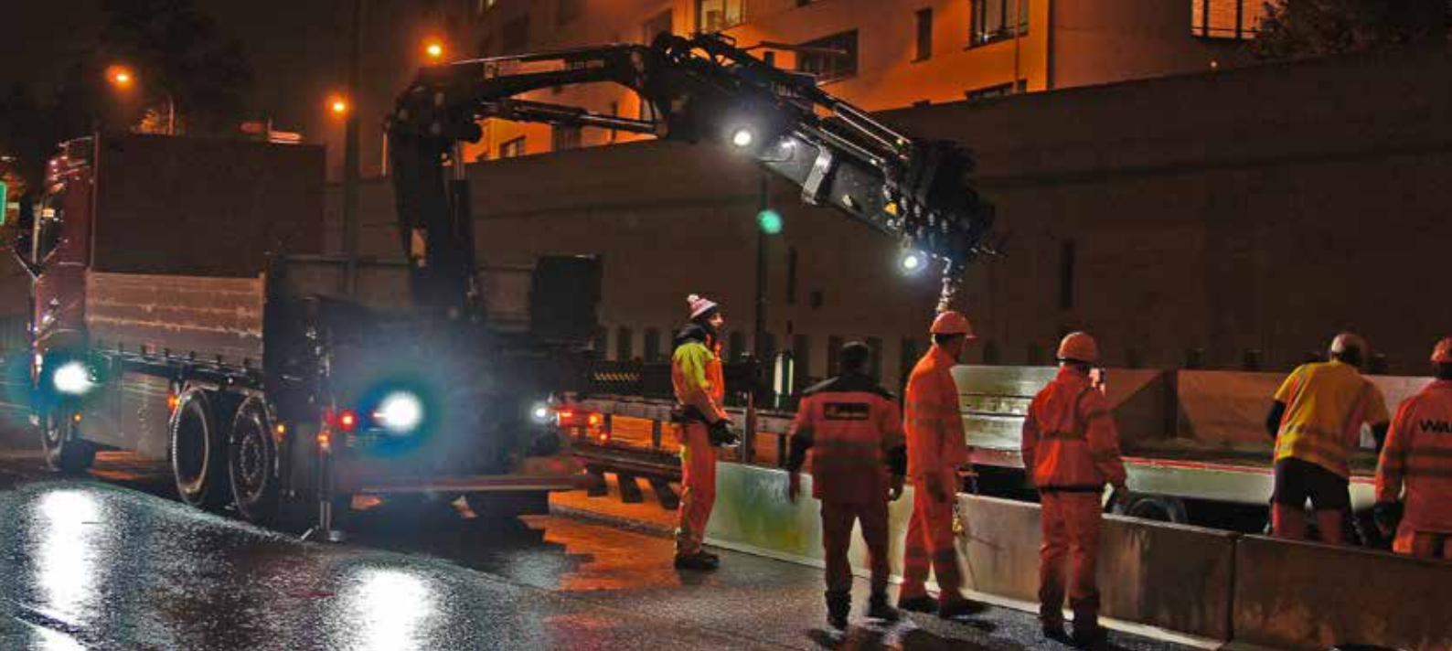
Präzises anfahren. Der Chauffeur steht in der richtigen Position und hat das Ladegut im Blick. Den Lastwagen kann er so exakt an die gewünschte Position fahren.
