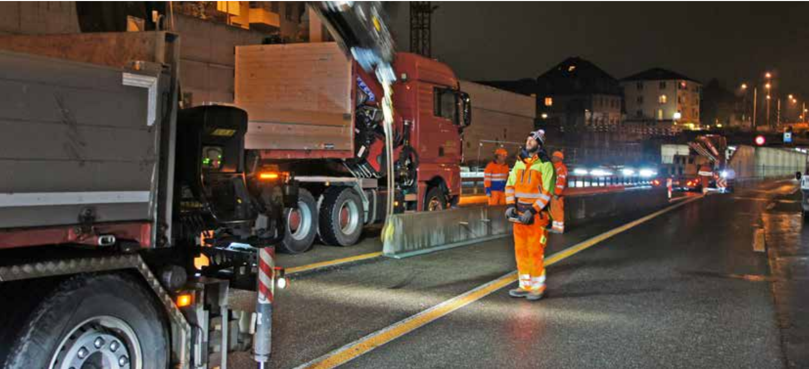
Wirtschaftliches "Spielzeug": Chauffeur und Kranführer in Einem. Stützen hoch, LKW zum nächsten Betonelement fahren, Stützen runter und nächstes Element aufladen. Mit derselben Fernbedienung ohne Ein- und Aussteigen.
